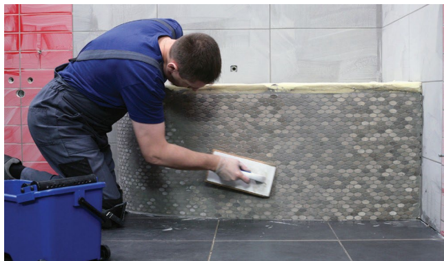
Profiliranje treba raditi kružnim pokretima
