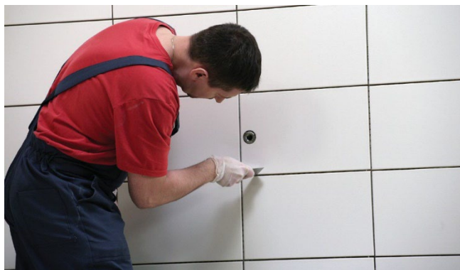
Čišćenje fuga pločica prije fugiranja
